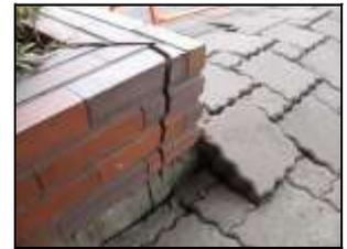
(液状化により損壊した新習志野図書館正面玄関前の様子)
