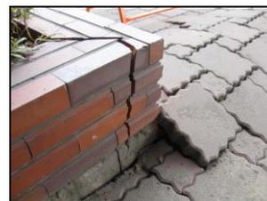
(液状化により損壊した新習志野図書館正面玄関前の様子)
